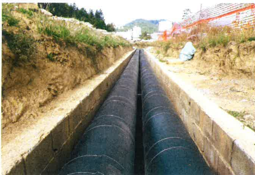
Slika 8: Obnovljena izolacija vročevoda (pogled v smeri J 5517)
