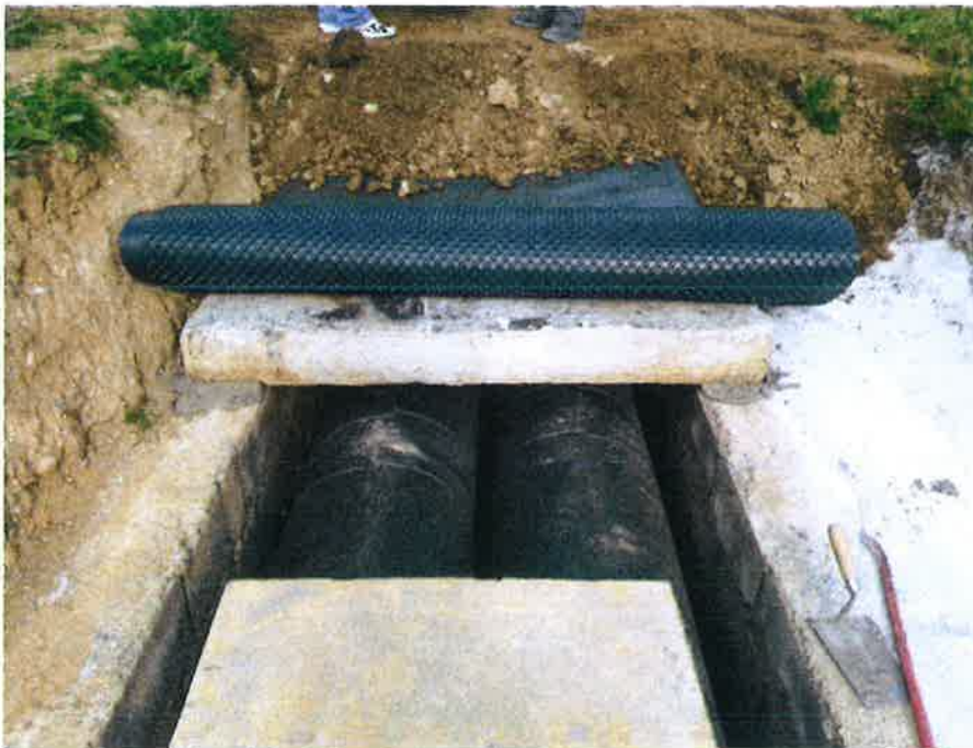
Slika 10: Pokrivanje kinete s krovnimi ploščami
