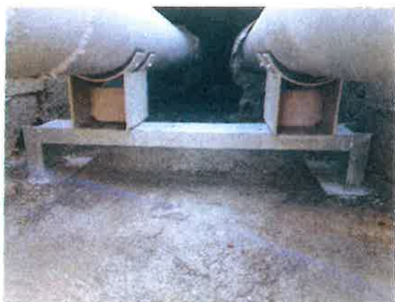
Slika 7: Zamenjava nosilcev in vgradnja drsnih podpor cevovoda (teflonski stik)
