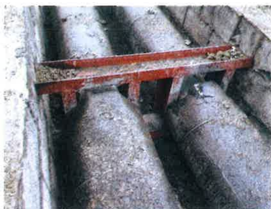
Slika 6 LEVO: Stanje fiksne podpore pred sanacijo; DESNO: Antikorozijska zaščita
