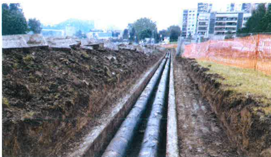
Slika 4: Odpiranje kinete vročevoda (pogled v smeri J 5035)
