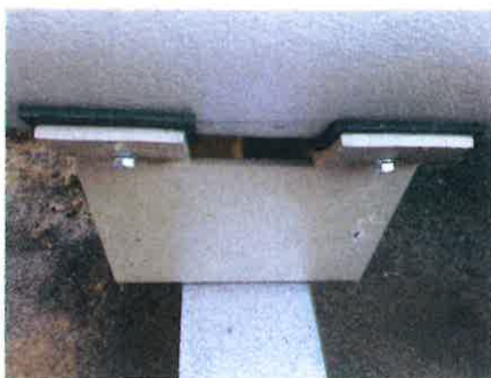
Slika 7: Zamenjava nosilcev in vgradnja drsnih podpor cevovoda (teflonski stik)
