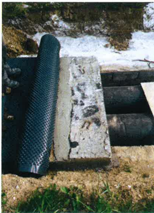
Slika 11: Tesnjenje stikov plošč in vgradnja čepaste folije
